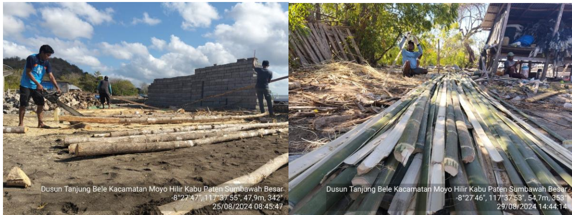
Gambar 4. Persiapan Alat dan Bahan untuk Pembangunan Instalasi Penjemuran Rumput Laut
