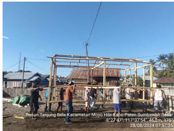
Gambar 5 Rangka Instalasi Penjemuran Rumput Laut
