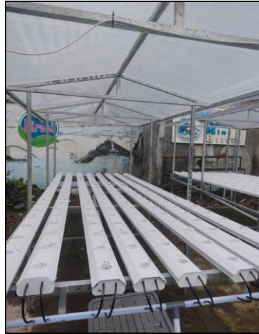
Gambar 1 Proses Perancangan Instalasi indroponik dengan talang gully
