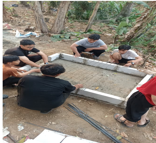
Gambar 2. Pembuatan Kerangka Rocket Stove
